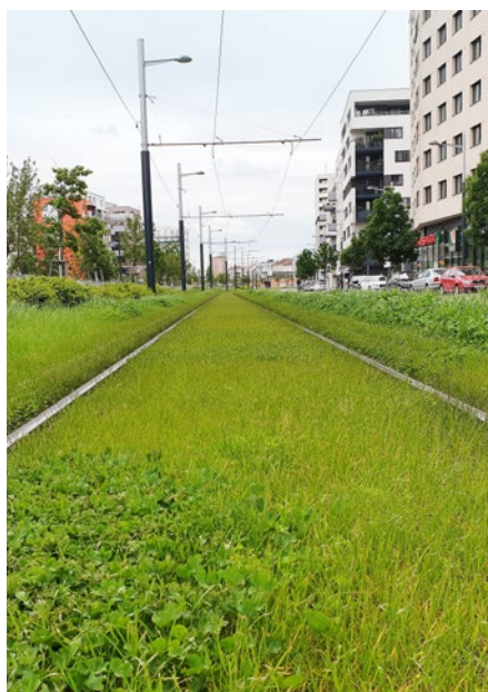
Abb. 6a, 6b und 6c: Einbau der Vegetationstragschicht und fertig begrüntes Gleis.
