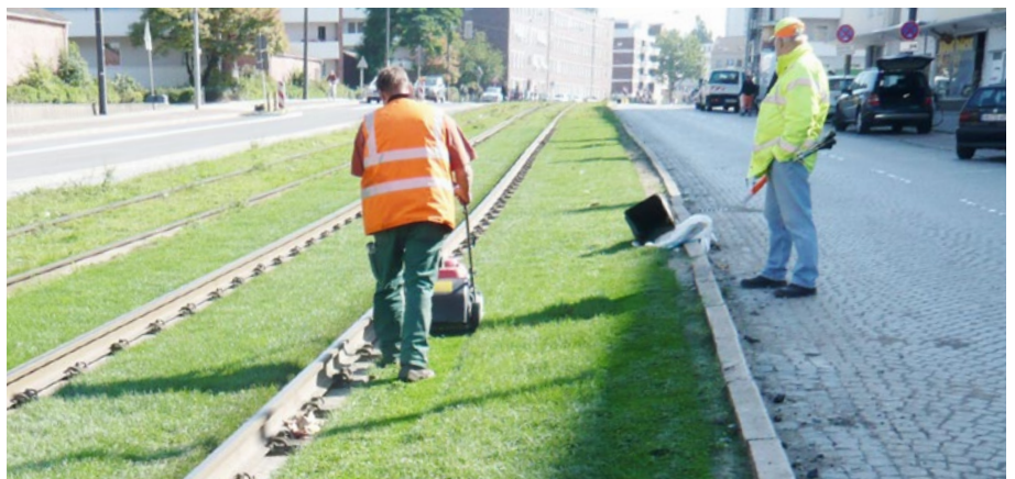
Abb. 3a und 3b: Mahd im tiefliegend eingedeckten Rasengleis. Oben: Mahd um die Schienenbefestigungen mit Freischneider. Unten: Mahd in der Fläche mit Handmäher.
