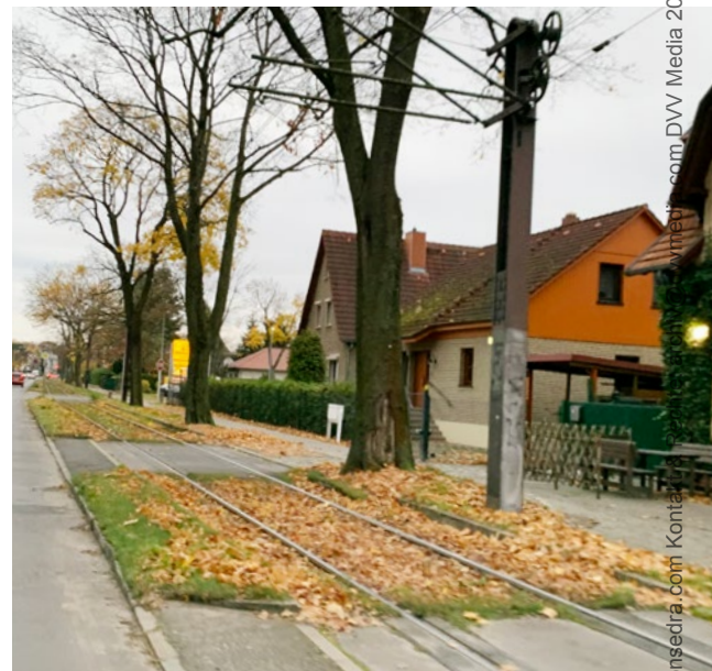
Abb. 1a und 1b: Links: Hochliegende Begrünung mit Rasen. Das Laub wird teilweise per Fahrtwind aus dem Gleis entfernt. Restliches Laub kann per Aufsitzmäher entfernt werden. Rechts: Tiefliegende Begrünung mit Sedum. Das Laub sammelt sich bis zum Schienenkopf im Gleis an und muss durch Gleisssauger entfernt werden.
