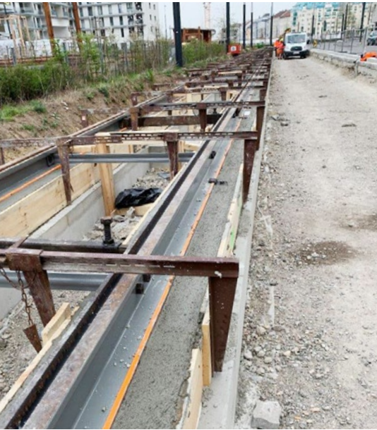
Abb. 5a, 5b und 5c: Einbau der beschichteten Schiene und fertig gestelltes Rasengleis, Wiener Linien, Linie D, Sonnwendviertel. Fotos: edilon)(sedra
