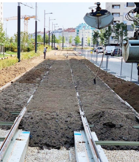
Abb. 6a, 6b und 6c: Einbau der Vegetationstragschicht und fertig begrüntes Gleis.
