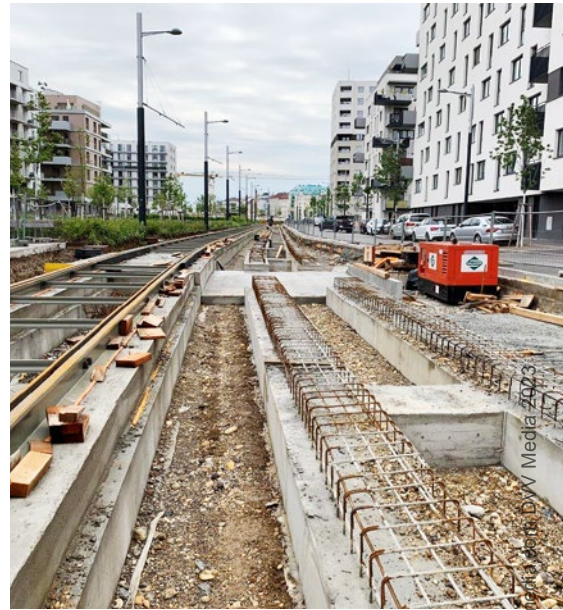
Abb. 5a, 5b und 5c: Einbau der beschichteten Schiene und fertig gestelltes Rasengleis, Wiener Linien, Linie D, Sonnwendviertel. Fotos: edilon)(sedra
