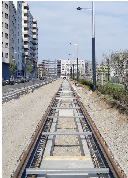
Abb. 5a, 5b und 5c: Einbau der beschichteten Schiene und fertig gestelltes Rasengleis, Wiener Linien, Linie D, Sonnwendviertel. Fotos: edilon)(sedra
